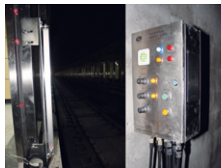
深圳地铁3号线老街站
