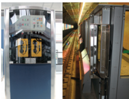
深圳地铁4号线二期工程高架站
